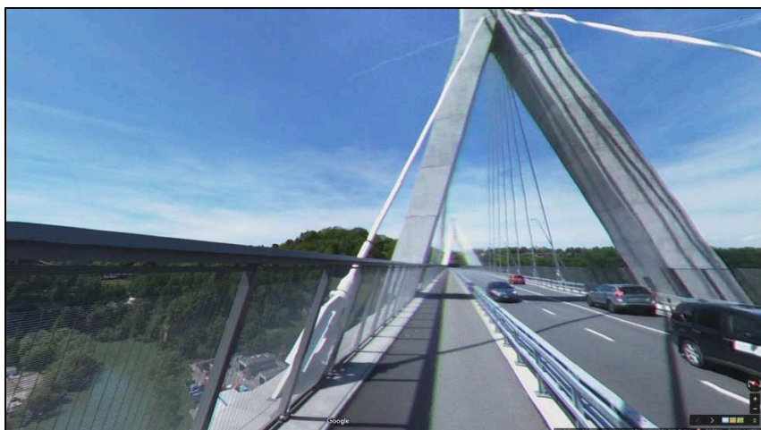
Figure 5 : pont de la Poya - Fribourg
